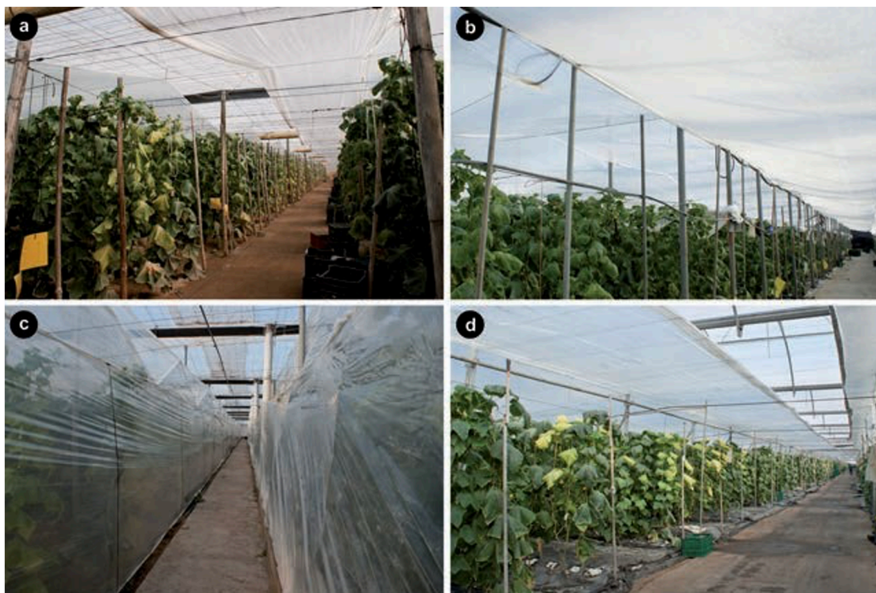
Fotografía 5. Distintas formas de mejorar la ventilación del invernadero abriendo el doble techo en los pasillos: a) lámina plástica sobre el pasillo que puede recogerse manualmente; b) manta térmica sobre el pasillo; c) cortinas plásticas verticales en los pasillos; y d) lámina plástica sobre el pasillo que puede recogerse de forma automática y sincronizada con las ventanas cenitales automatizadas.
