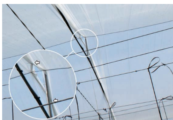
Fotografía 4. Detalle de las lañas que unen las láminas plásticas en un doble techo fijo con las láminas perpendiculares a las líneas de cultivo (izquierda) y de los agujeros realizados en el amagado para evacuar del agua (derecha).
