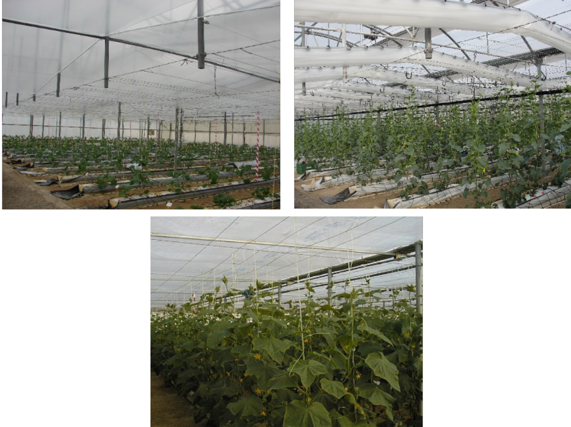
Fotografía 16. Invernadero multitúnel con doble techo fijo de plástico (arriba izquierda) y multitúnel con doble techo móvil de plástico (arriba derecha), e invernadero parral con doble techo de manta térmica (abajo).
