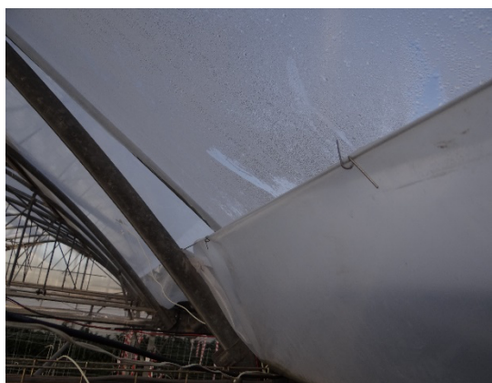
Fotografía 4. Distintos tipos de canaletas para la recogida de agua de condensación.
