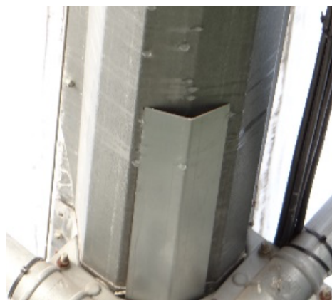
Fotografía 4. Distintos tipos de canaletas para la recogida de agua de condensación.
