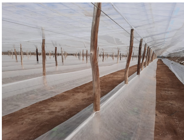
Tunelillos con manta térmica
