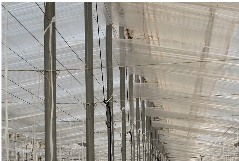
Fotografía 6. Doble techo en escalón con láminas perpendiculares a las líneas de cultivo y separadas verticalmente.
